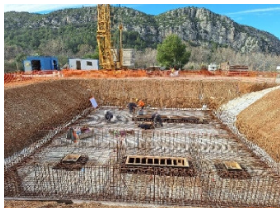
construction de l'usine de traitement
