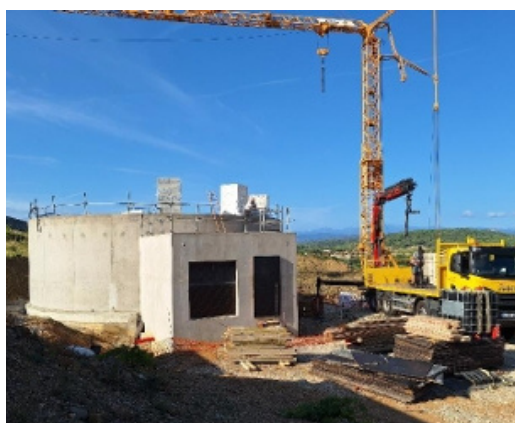
Construction d'un réservoir d'eau potable pour Tautavel et pose des canalisations de distribution d'eau potable
