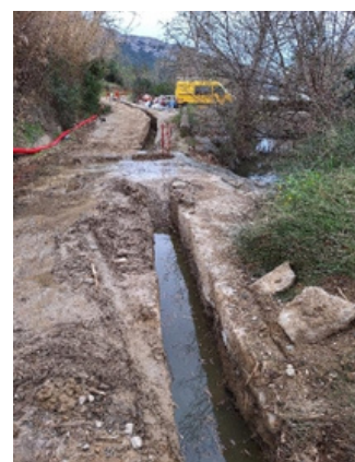
Construction d'un réservoir d'eau potable pour Tautavel et pose des canalisations de distribution d'eau potable
